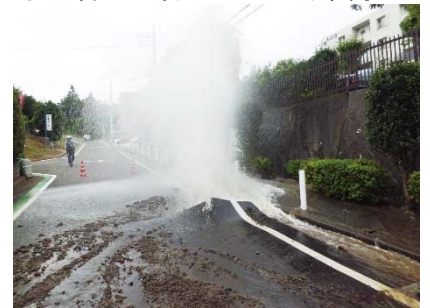
水道管の老朽化による破裂事故
