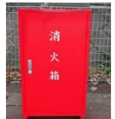
初期消火箱（固定式）
