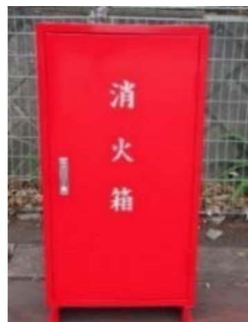
初期消火箱（固定式）
