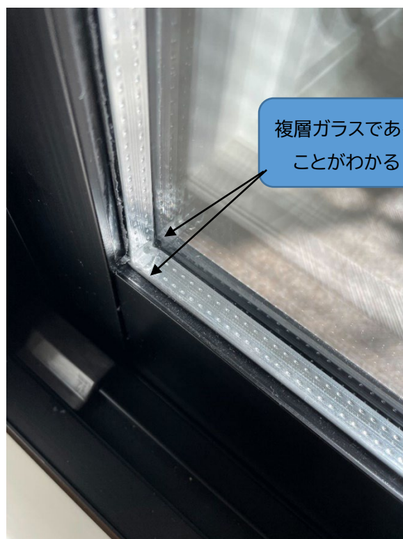
②斜めから撮影した写真
