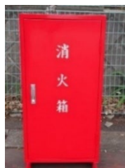
初期消火箱（固定式）
