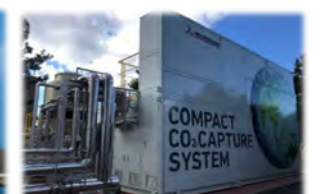
焼却工場のCO 2 回収(CCUの実証試験)
