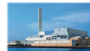
工場の新設・長寿命化工事
