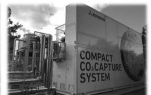
焼却工場のCO<sub>2</sub>回収 (CCUの実証試験)
