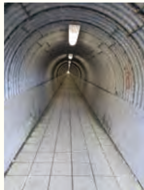
大原隧道内部
