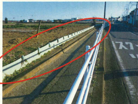
○ 対策例：畑に土留め板を設置
