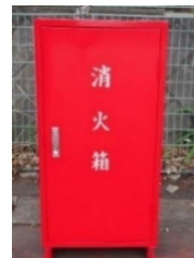
初期消火箱（固定式）
