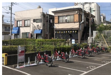
集合住宅の空き駐車スペースを活用した設置例
