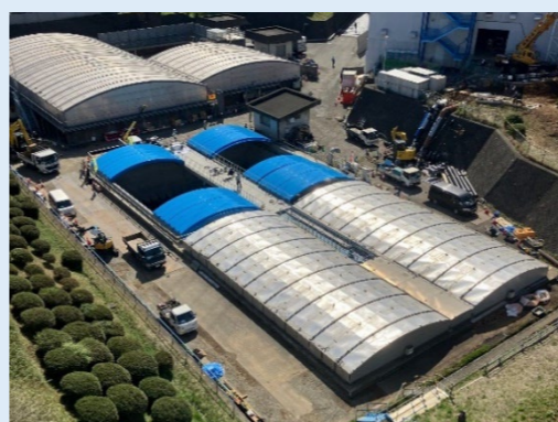
写真4 排泥池の補修
