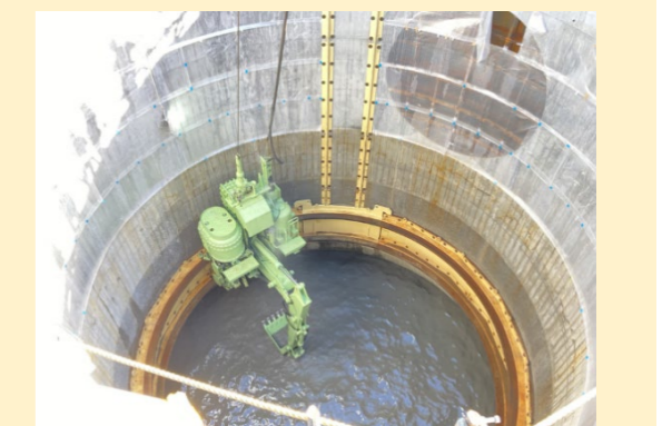
写真6 立坑築造工
