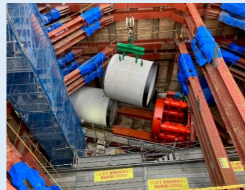
写真2 場内管路切り回し工
