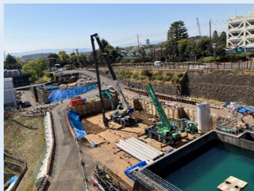
写真3 排水池の新設
