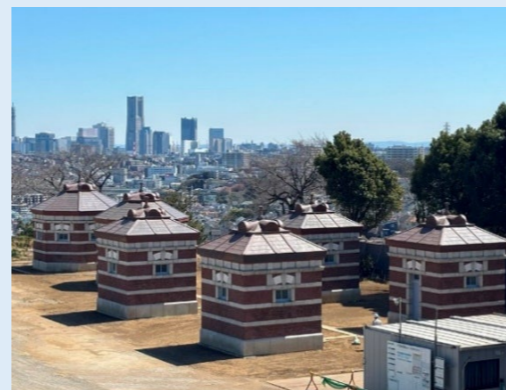
写真1 国登録有形文化財の移設完了
