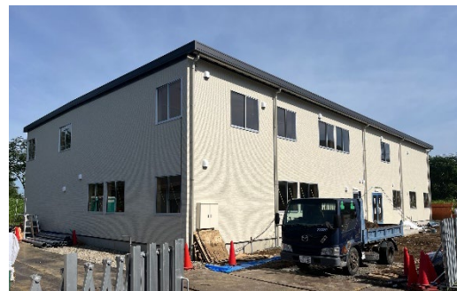
事務所外観（7月2日時点：工事中）
