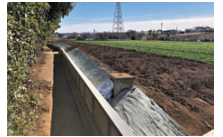
土砂流出防止対策/都筑区
