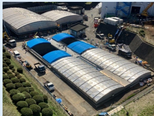
写真4 排泥池の補修
