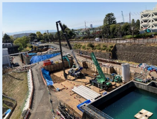
写真3 排水池の新設
