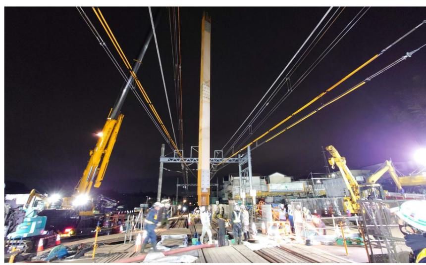
シールドマシン発進に必要な立坑をつくるため、土留壁工事を実施しています。線路の下に土留壁を設置する必要があるため、電車の運行が終了した後、線路を取り外して、作業を行っています。近隣にお住まいの方などの安全に十分配慮して、工事を進めていきます。
