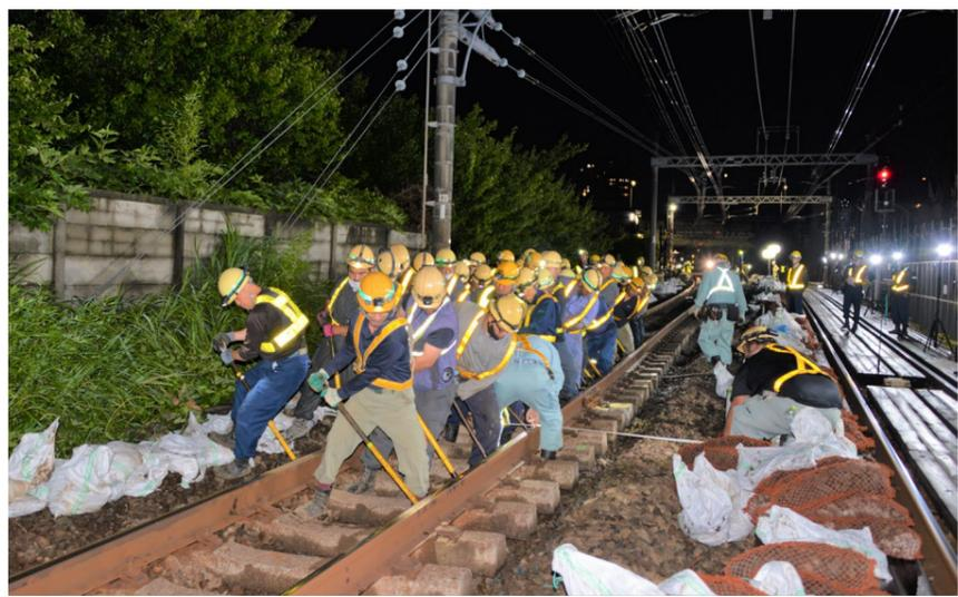
6月に下り線の線路切替えを実施しました。現場は狭小であり、機械施工が困難なため、総勢169名による人力作業で行いました。今後は、既存の線路設備の撤去及び地下構造物を作るための土留壁工事を行っていきます。近隣にお住まいの方や踏切を利用する方などの安全に十分配慮し、工事を進めていきます。
