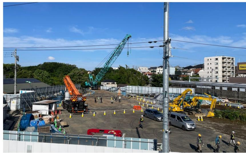
鶴ヶ峰駅北口に位置する作業ヤード内には、地下に新たな鶴ヶ峰駅を建設します。建設に必要な土留壁工事のための準備作業として重機の組立及び資材の搬入を行っています。近隣にお住まいの方や鶴ヶ峰駅を利用する方などの安全に十分配慮し、工事を進めていきます。
