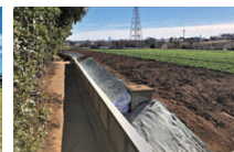
土砂流出防止対策／都筑区
