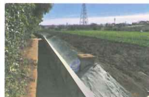
土砂流出防止対策／都筑区
