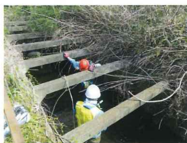
一部暗きょ化されたコンクリート製の水路
