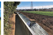
土砂流出防止対策/都筑区
