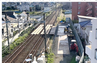
【② 瀬谷地内線 相鉄線路内工事の様子】
