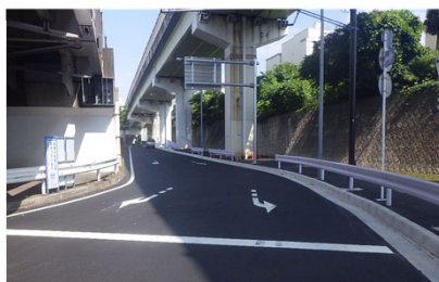
【③ 上川井IC出口 拡幅工事完成】
