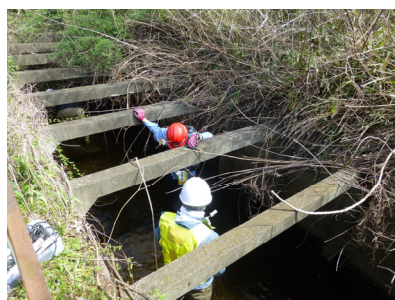
一部暗きょ化されたコンクリート製の水路
