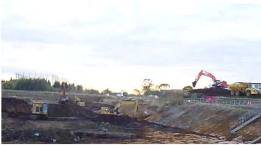
相沢川調整池（地下式）工事状況
