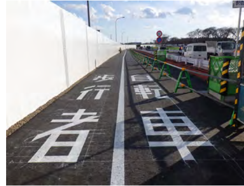
切り替え後のバイパス道路【1】の自転車歩行者道
