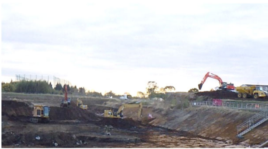
相沢川調整池（地下式）工事状況
