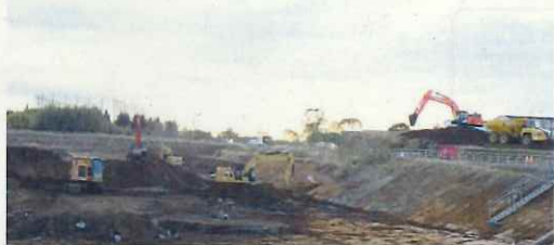
相沢川調整池（地下式）工事状況
