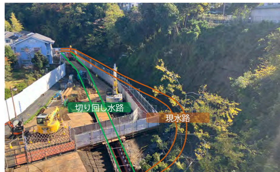
第2工区 【親水緑道の水路切り回し工事を実施しています】
