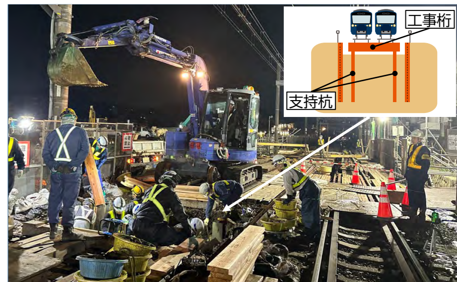
第1工区 【工事桁を架ける準備工事を実施しています】
