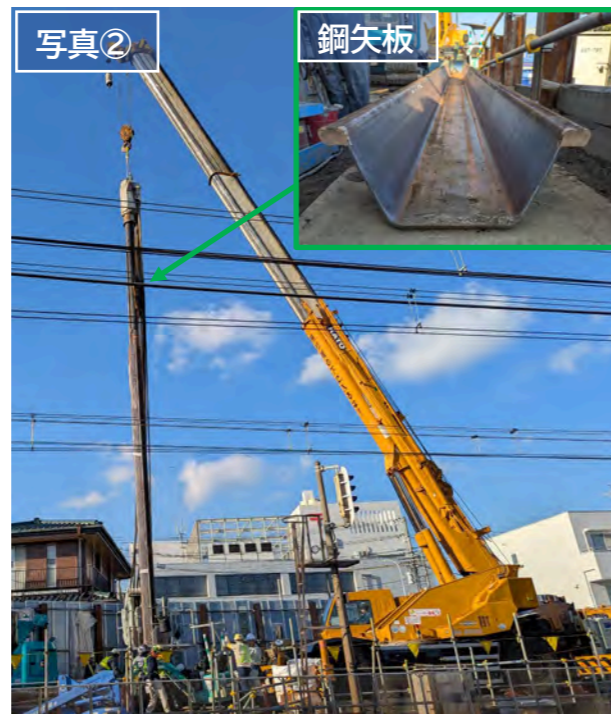
写真② 約18mの鋼矢板を地中に打ち込んでいきます。
