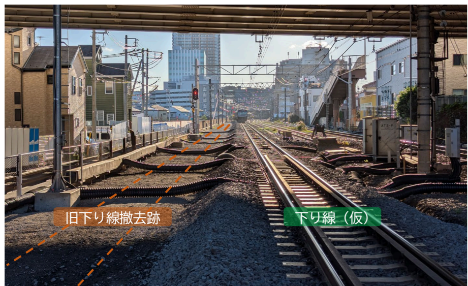
第3工区 【旧下り線の撤去が完了しました】
