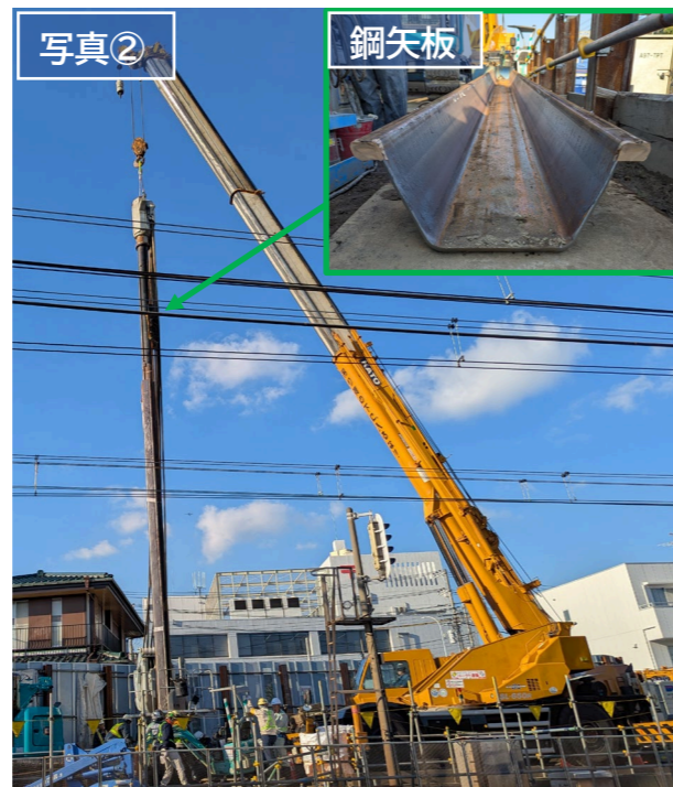
写真② 約18mの鋼矢板を地中に打ち込んでいきます。
