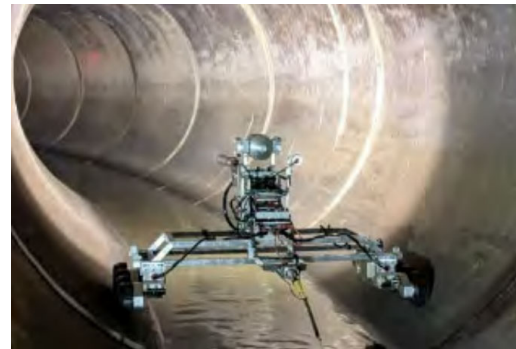
中大口径管の調査状況
