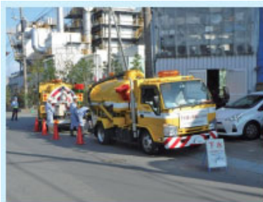
下水道管の清掃
