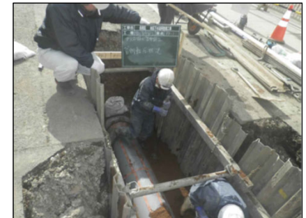
開削工法施工状況
