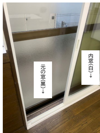
↑窓の断熱化（内窓の設置）
