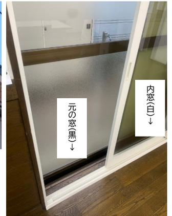
↑窓の断熱化（内窓の設置）
