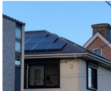
↑太陽光パネルの設置
