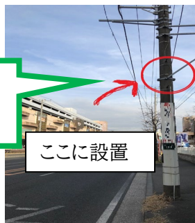
良い例(全景が確認できる)
