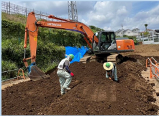
写真 3 レンガ片の除去（手作業）
