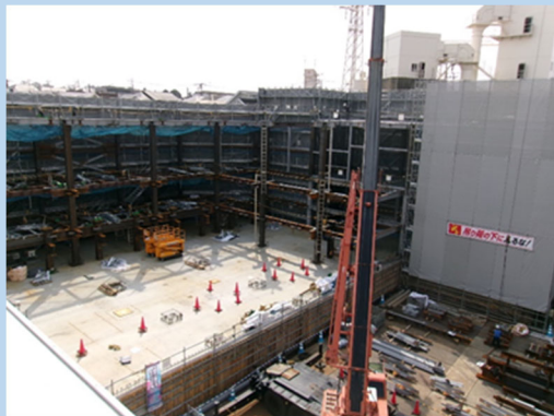
写真 4 脱水機棟築造工
