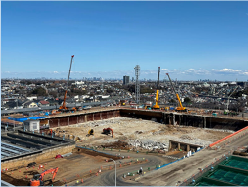
写真 1 旧配水池解体工
