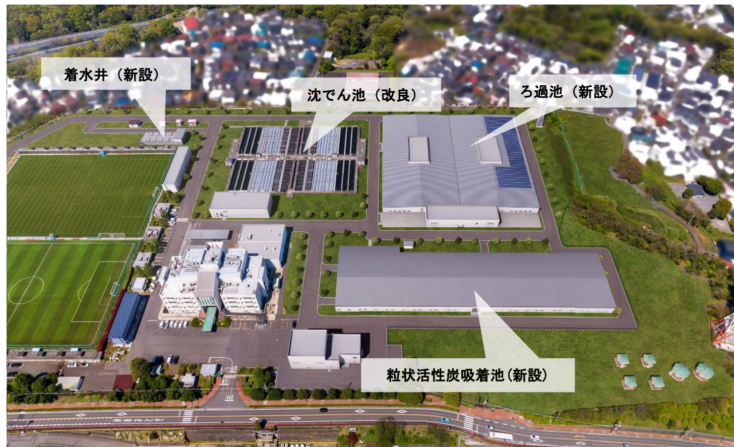
浄水処理施設完成予想図（令和 16 年度完了予定）
