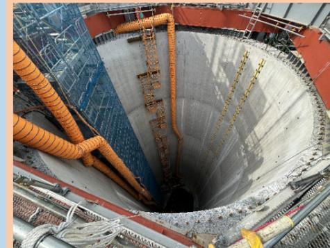
写真5 西谷立坑築造工
