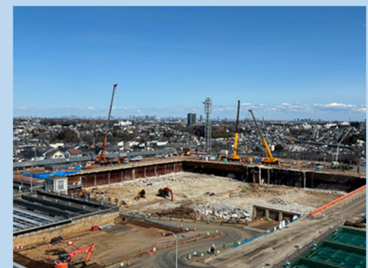
写真 1 旧配水池解体工
