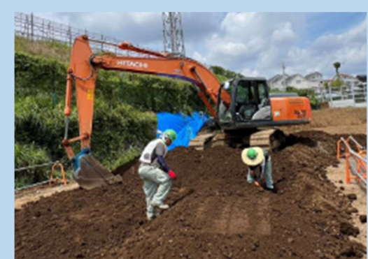
写真 3 レンガ片の除去（手作業）
