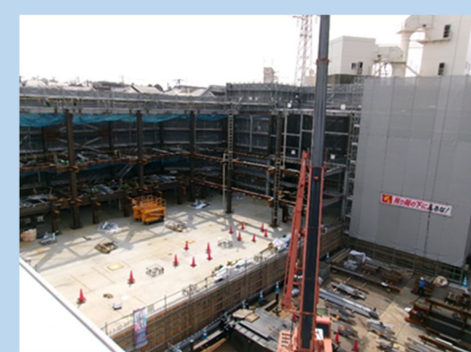
写真 4 脱水機棟築造工
