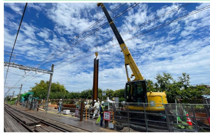
鶴ヶ峰8号踏切付近にて、掘削時に土が崩れてこないようにするため、線路沿いの地中に約25mの壁(土留壁)を作っています。今後、鶴ヶ峰8号踏切付近から二俣川駅にかけて同様に土留壁の設置を行っていきます。
