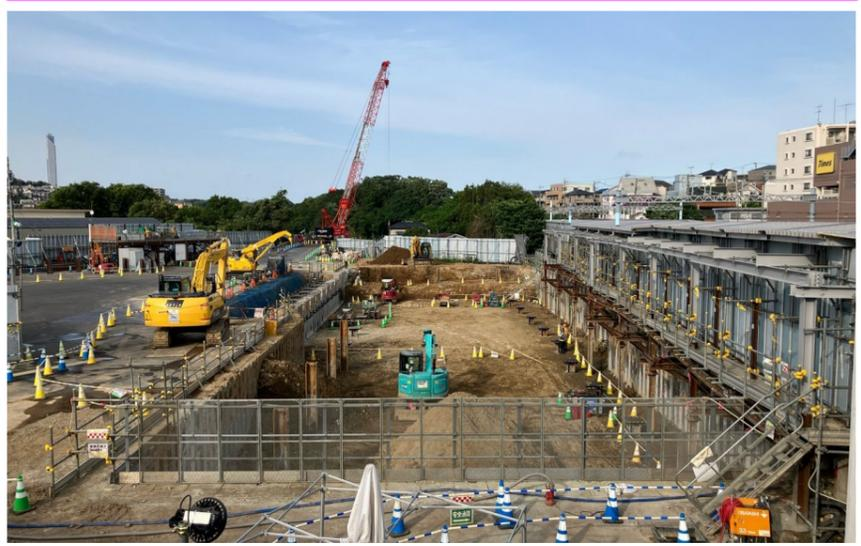
地下に駅舎を構築するために掘削作業を開始しました。この作業ヤードでは現在約3mの深さまで掘削が進んでいます。地下約35mまで掘削を行った後、シールドマシンを通過させます。
