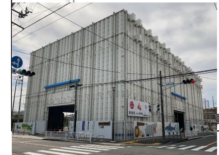
作業基地外観(防音ハウス設置)
