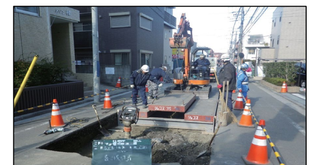
開削工法施工状況
