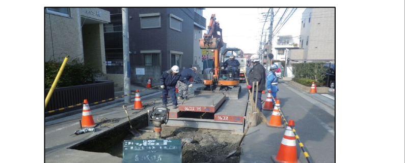
シ 開削工法施工状況
