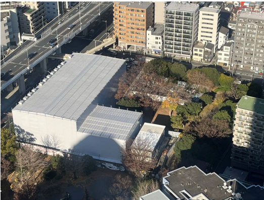
現在(R7.12月)の工事基地の様子
