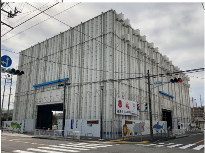
作業基地外観(防音ハウス設置)
