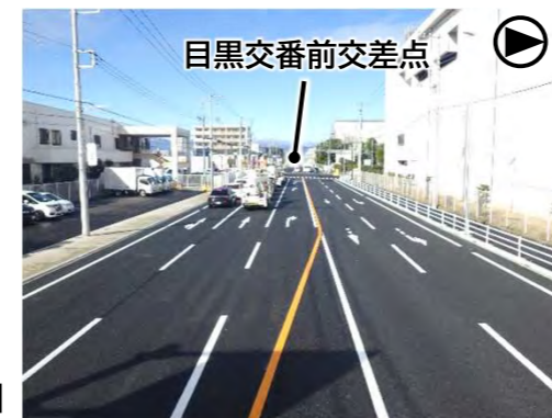
【工事状況(目黒交番前交差点付近)】
