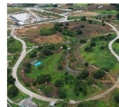
【和泉川源流部周辺の整備状況】
