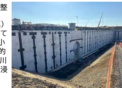
【相沢川調整池(地下式)の工事状況】
