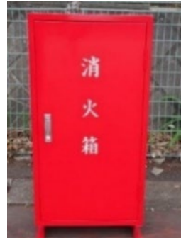
初期消火箱（固定式）
