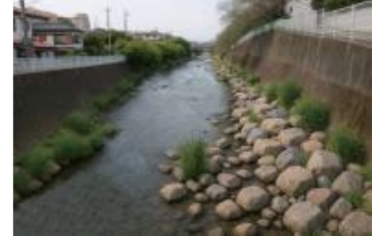
人々の憩いの場となる水辺空間の形成を目指すため、河床及び水際の自然環境を創出し活用する川づくり
