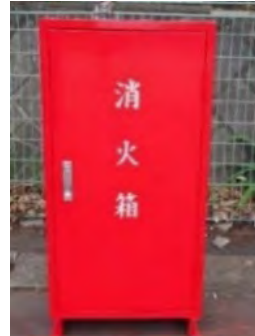
初期消火箱（固定式）
