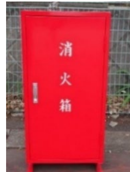
初期消火箱（固定式）
