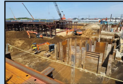
写真1 既設配水池解体完了
