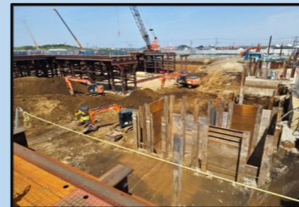
写真1 既設配水池解体完了
