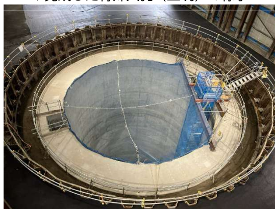
▽完成した特殊人孔（立坑）の様子
